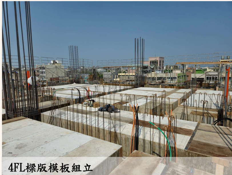
4FL樑版鋼筋綁紮及水電配線
